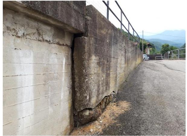
Vista della zona interessata dalle opere di sottofondazione e contromuro a rinforzo della parete di sostegno del terrapieno sulla rampa a est dell'area di intervento.
